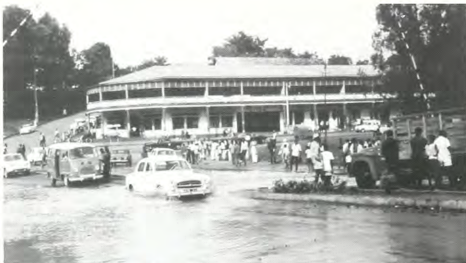
Yaoundé : inondation de la gare
