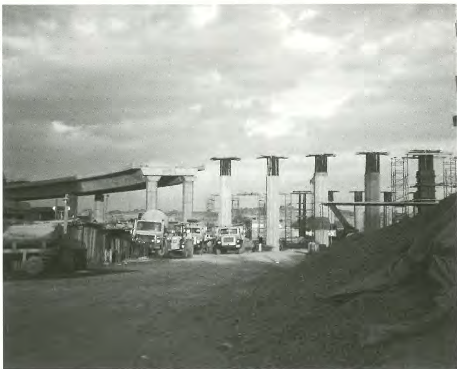
La «ring road» chantier du pont sur le Nil en février 1996, les bretelles d'accès
